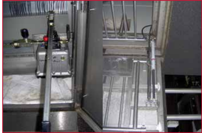
HS-8 schachtafdekking uitgevoerd met hydraulische cilinder. Opdrachtgever : Provincie Overijssel Details afdekking : HS-8 Kl.D 400kN 2300x1100mm
