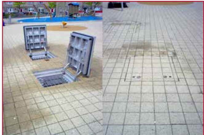
HS-8 schachtafdekking uitgevoerd met geïntregeerd straatwerk in de deksel waardoor het aanzicht gehandhaaft blijft. Opdrachtgever : Waternet (Amsterdam) Details afdekking : HS-8 Kl.D 400kN 850x850mm
