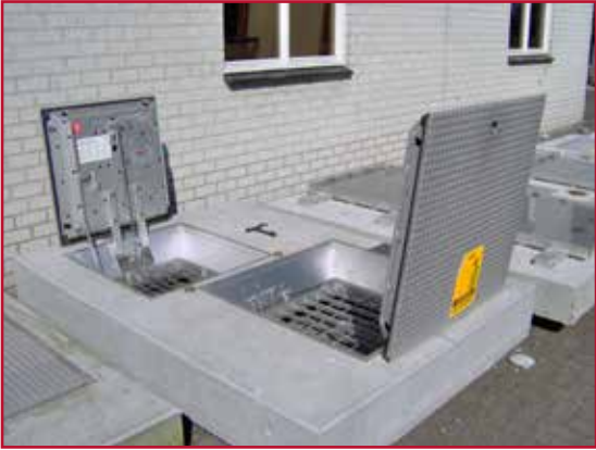
HS-8 schachtafdekking uitgevoerd in betonomranding Opdrachtgever: Gemeente Amstelveen Details afdekking: HS-8 Kl.D 400kN 600x600mm & 800x800mm
