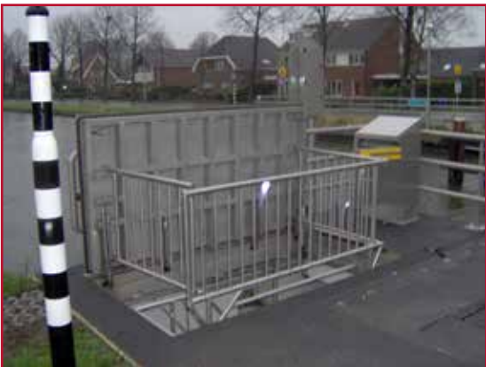
HS-8 schachtafdekking uitgevoerd 3-delig hekwerk Opdrachtgever : Provincie Overijssel Details afdekking : HS-8 Kl.D 400kN 2300x1100mm
