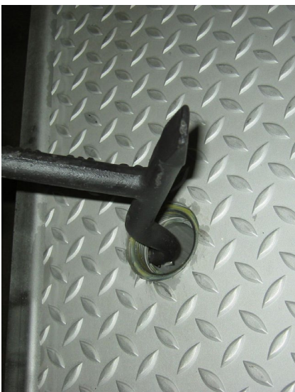
Afb. 3 Sleutel inhaken en deksel open trekken
